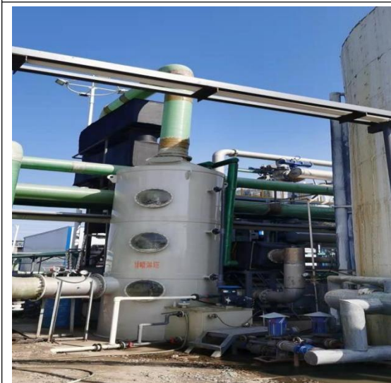
图 4.1-9 总管碱喷淋装置
