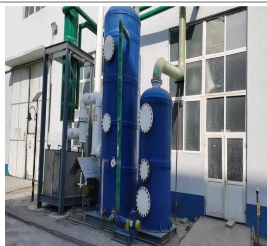
图 4.1-5 二车间冷凝喷淋装置
