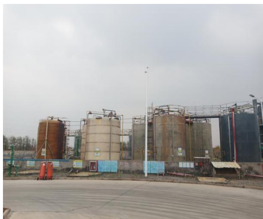
图 4.2-13 罐区围堰
