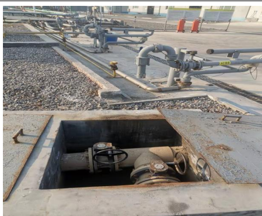
图 4.2-16 雨污切换阀
