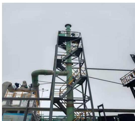
图 4.2-19 废气排气筒
